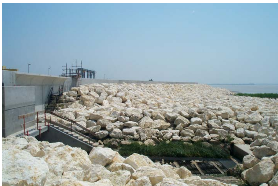
Figure 5 - Vue globale des ouvrages réalisés (profil courant et profil singulier au droit du rejet)
